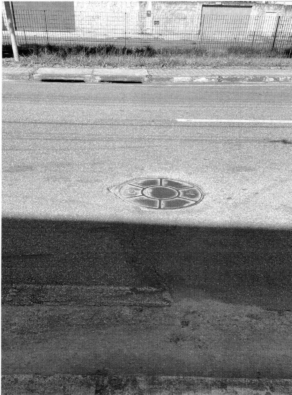
MANUTENÇÃO E NIVELAMENTO DA TAMPA DE ESGOTO LOCALIZADA NA AVENIDA JULIO SIMÕES, EM FRENTE AO NUMERO 1059. VILA CECILIA- MOGI DAS CRUZES.
